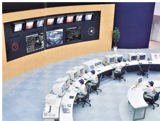
24時間体制の運転・監視の様子
