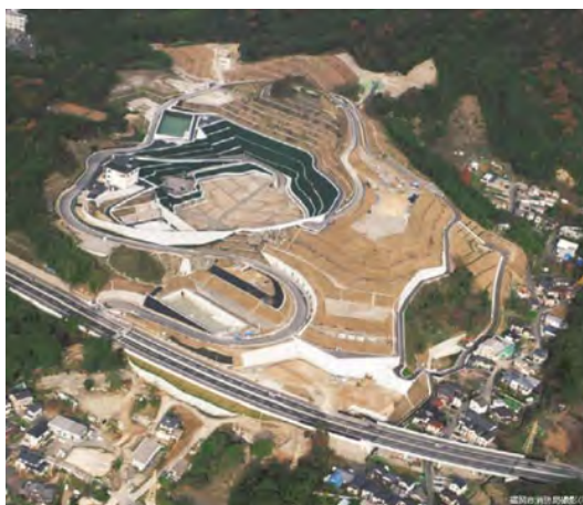
図2-10 福岡都市圏南部最終処分場
