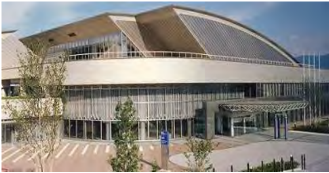
図3-7 総合西市民プール
