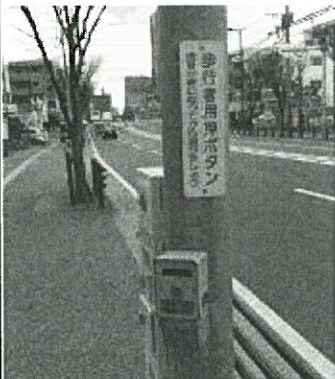
歩行者用押ボタンの電球切れで「おまちください」の表示が出ないようなときは警察に連絡すると対応してくれます。
