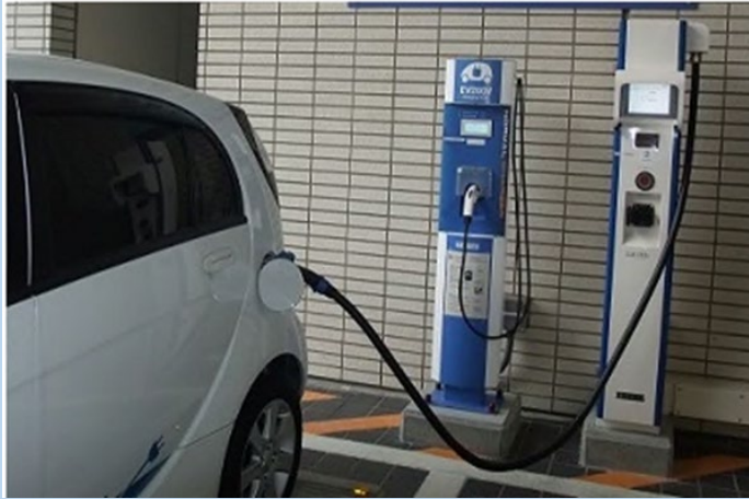
福岡市役所 1 階駐車場
