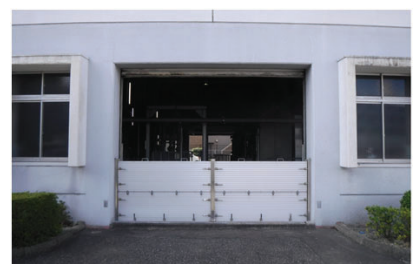
▲止水板 設置時
