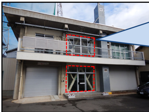
▲耐震補強したポンプ場
