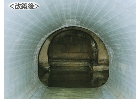
▲内側から改築した下水管
