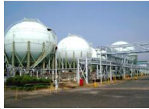
西部ガスLNG基地
