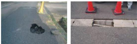
舗装の破損、くぼみ、穴 側溝・側溝蓋の破損
