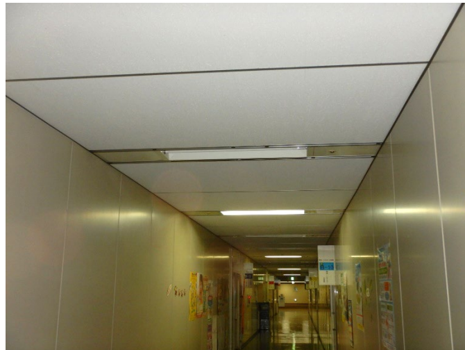
福岡市役所の廊下における間引きの状況
