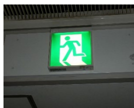
福岡市役所に設置されている LED 式誘導灯（写真左）と蓄光式誘導標識（写真右）
