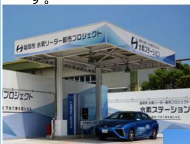
▲下水から水素をつくる世界初の水素ステーション
