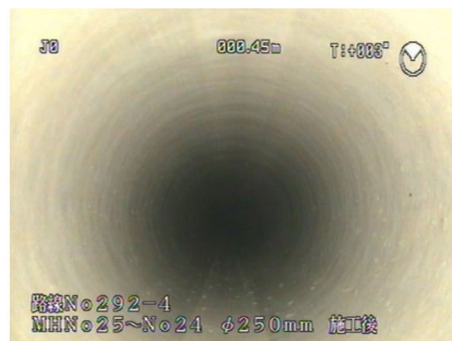
施工後（管更生）
