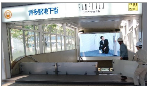
地下街管理者による止水板設置
