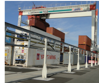
■トランスファークレーンの電動化 RTG Electrification
