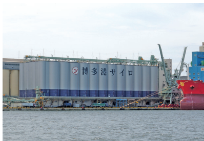
■穀物サイロ Grain silo
