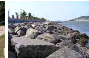
＜生きものの生息に配慮した護岸＞
