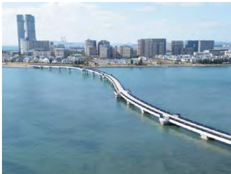
<海上遊歩道(あいたか橋)>
