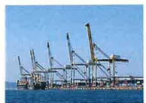
アイランドシティコンテナターミナル
