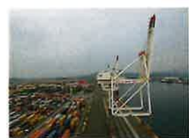
アイランドシティコンテナターミナル
