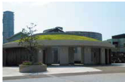
屋根を緑化したトイレ
