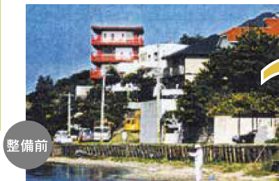
木杭等で崩落を防止していた海岸線
