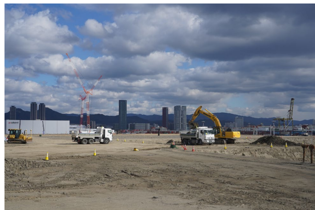
二次覆土撤去（市4の3工区）
