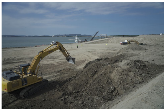
二次覆土撤去（市4の3工区）
