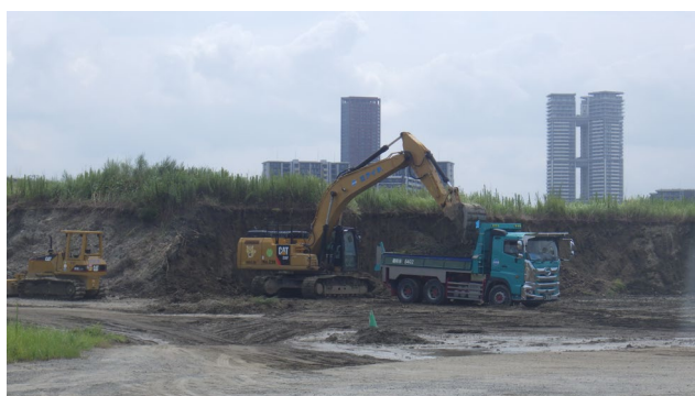
二次覆土撤去（市5の3工区）
