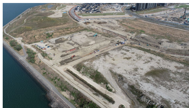
二次覆土撤去（市5の3工区）
