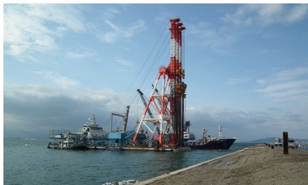
岸壁（-15m）岸壁築造（サドコンパクション）
