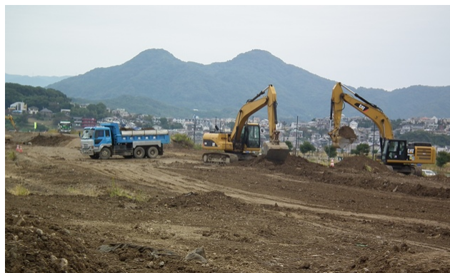
市5の3工区 地盤改良（覆土撤去）
