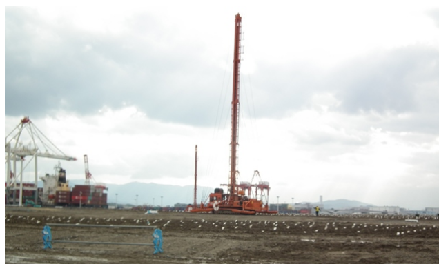
市3の2の2工区 地盤改良（ドレーン打設）
