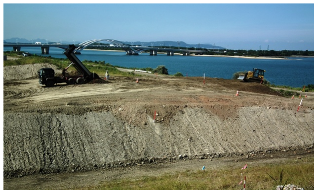
市5の3工区 地盤改良（二次覆土）
