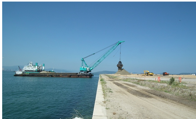
市3の2の2工区 地盤改良（敷砂）
