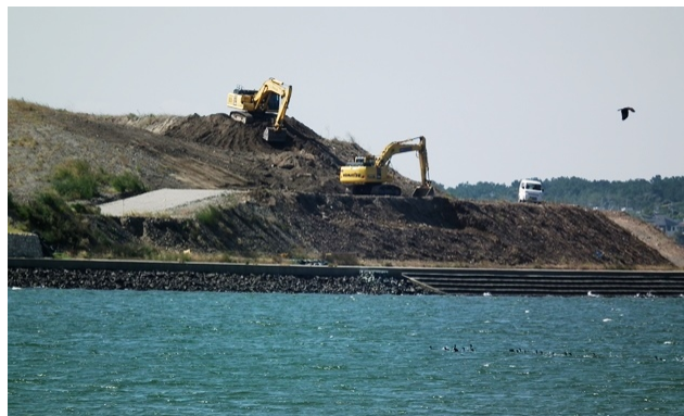
市5の3工区 土地造成
