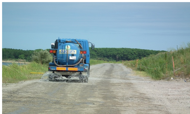
工事区域内の散水
