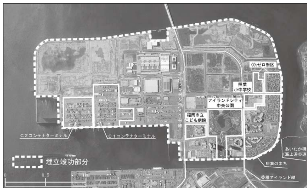
事業の進捗状況（平成 28 年 5 月 12 日撮影）
