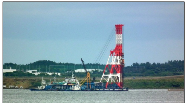
市3の2の2工区 A護岸築造 (サンドコンパクション)
