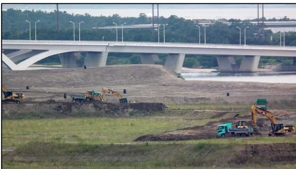
市5の3工区 (覆土撤去)
