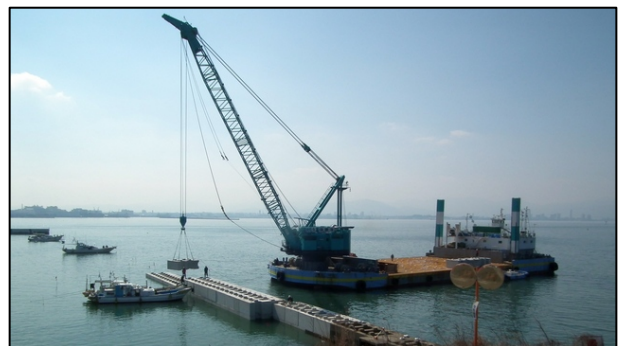
市3の2の2工区 A護岸築造 (ブロック据付)
