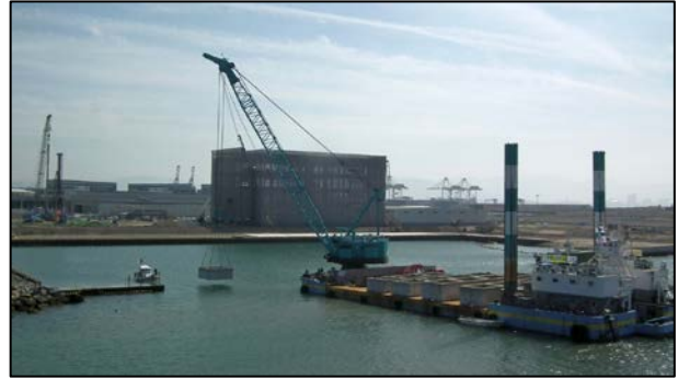
市2工区 防波堤築造 (ブロック据付)
