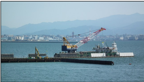
市3の2の2工区 仮締切堤築造 (上部工)
