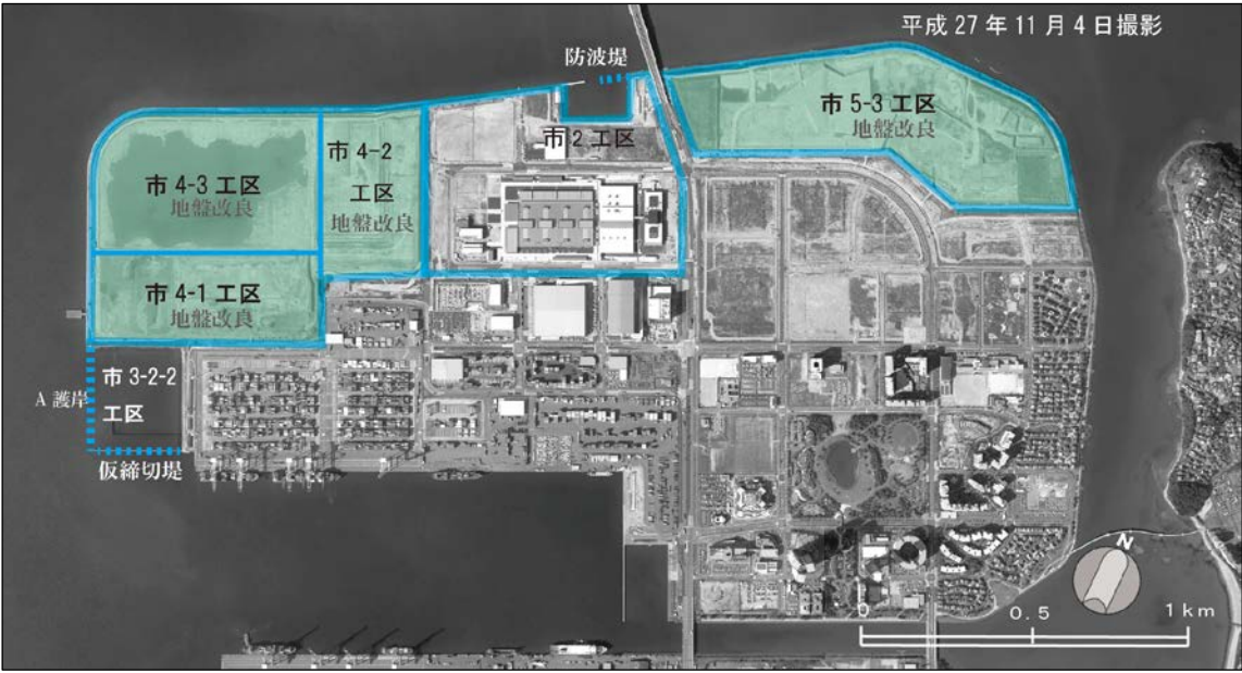
図 1 平成 27 年度工事区域
