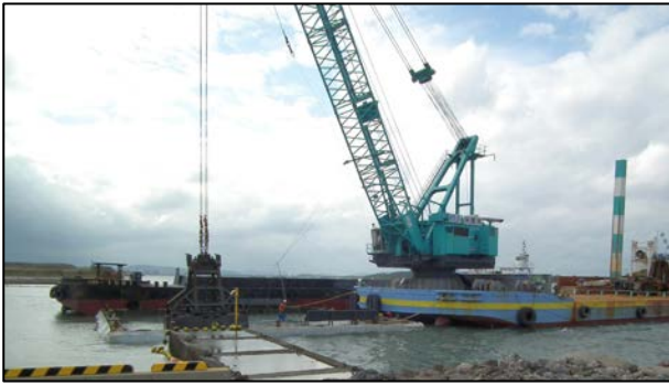
市2工区 防波堤築造 (床掘)
