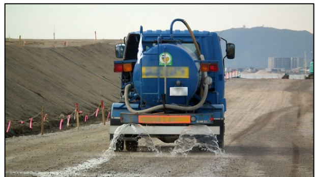
工事区域内の散水
