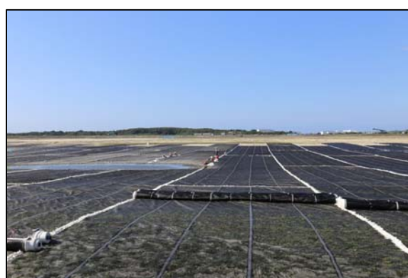
市4の3工区 表層処理(補強材敷設)
