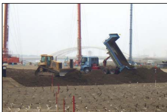
市4の1工区 地盤改良 (ドレーン(手前と奥), 二次覆土(中間))
