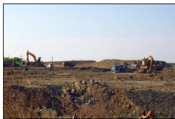
市5の3工区 覆土撤去
