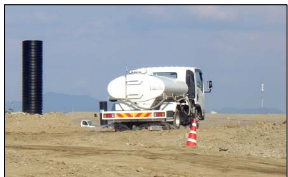
工事区域内の散水
