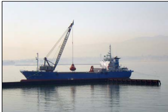
市3の2の2工区 仮締切堤築造 (基礎捨石投入)
