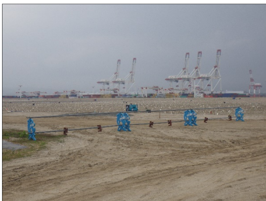
工事車両の通行制限
