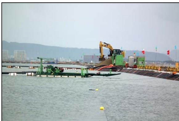
市4の3工区 表層処理(敷砂)
