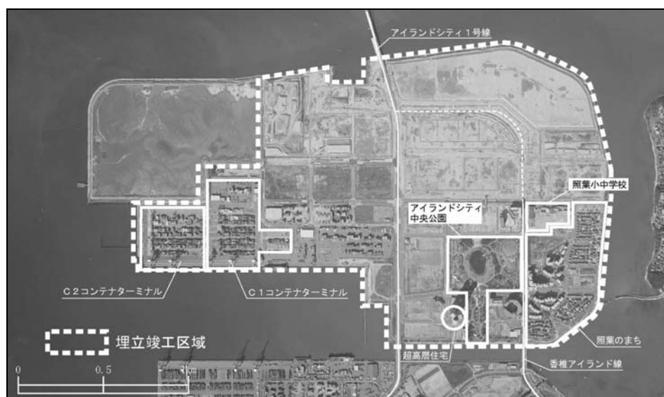
事業の進捗状況（平成 23 年 11 月 16 日撮影）
