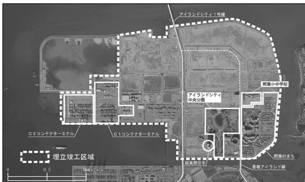
事業の進捗状況（平成 22 年 11 月 4 日撮影）
