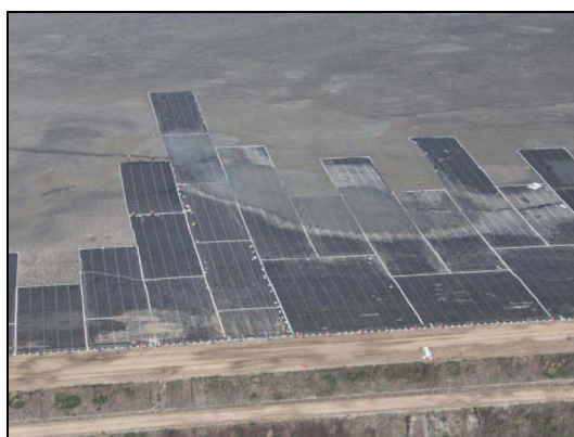
市 4 工区の表層処理（補強材敷設）
