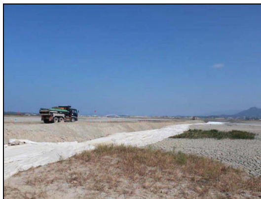
市 4 工区の間仕切築堤
