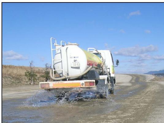
工事区域内の散水
