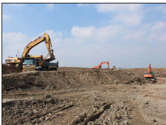
市 5 の 2 工区の覆土撤去
