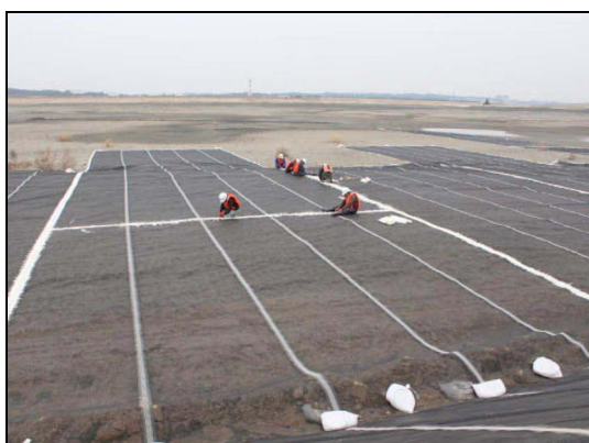
市 4 工区の表層処理（補強材敷設）
