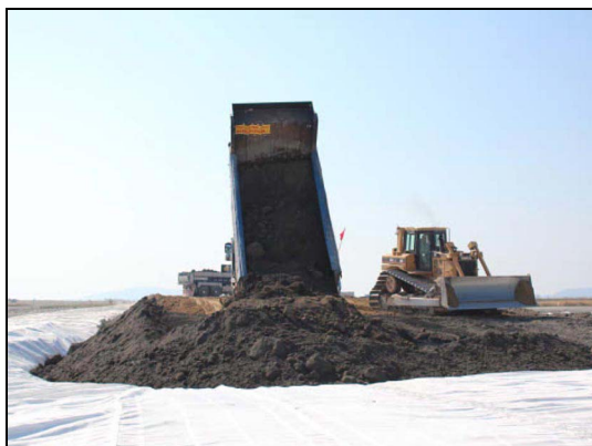
市 4 工区の間仕切築堤
