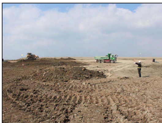
市 5 の 3 工区の二次覆土
