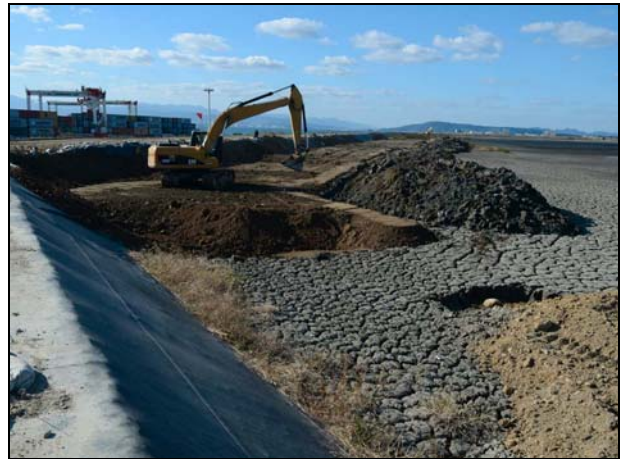
市 4 工区の埋立（築堤拡幅）
