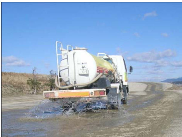
工事区域内の散水
