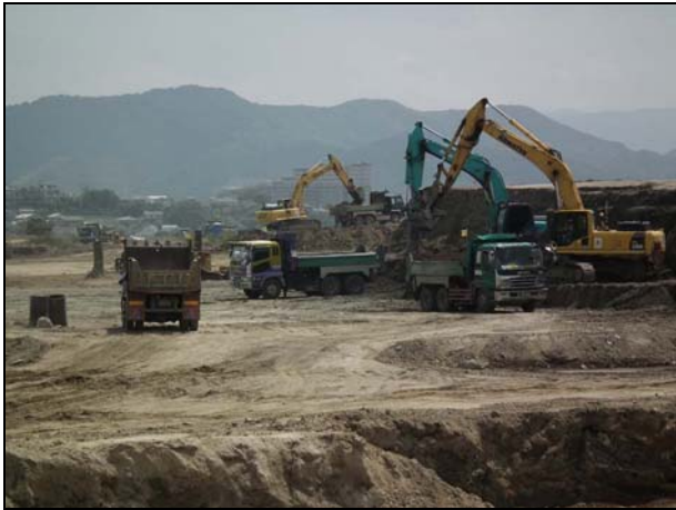
市 5 の 2 工区の覆土撤去
