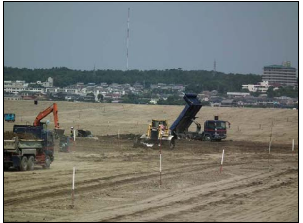
市 5 の 3 工区の二次覆土
