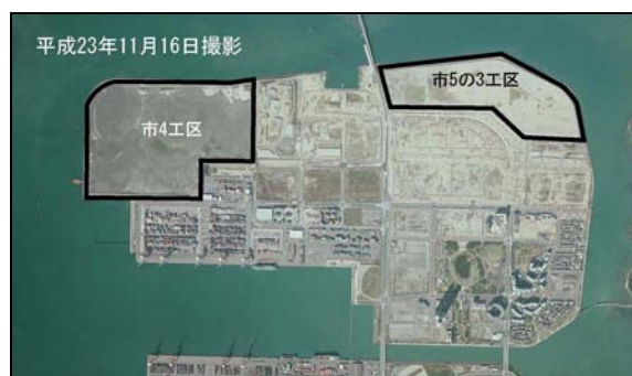
図5 工事の進捗状況
