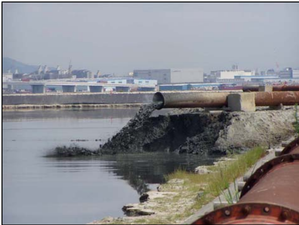
市 4 工区の埋立（土砂投入）
