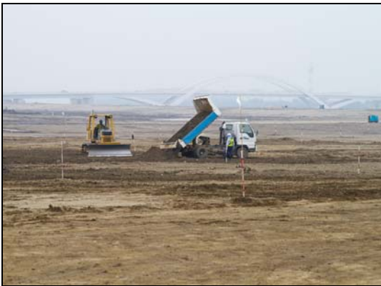
市5の3工区の一次覆土
