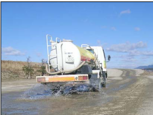
工事区域内の散水
