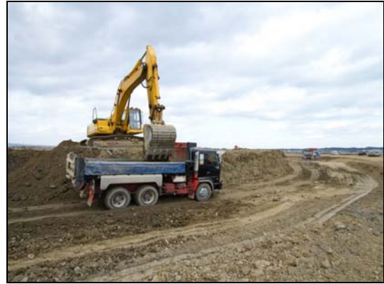
市5の2工区の覆土撤去
