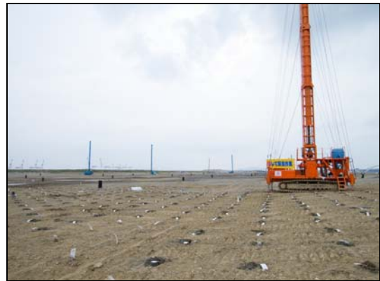
市5の3工区のドレーン工
