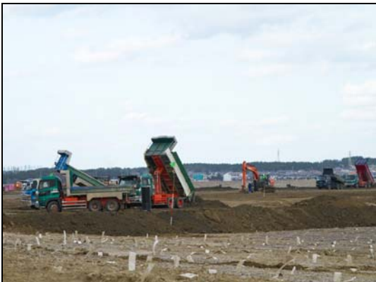
市5の3工区の二次覆土
