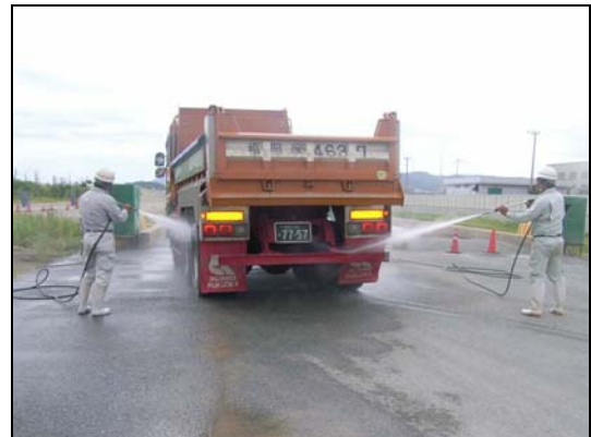
車両洗浄施設
