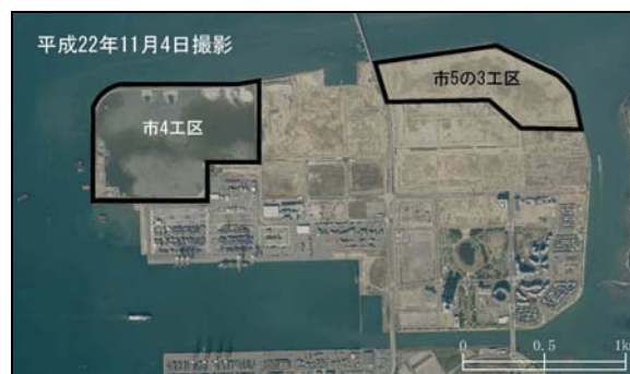
図6 工事の進捗状況
