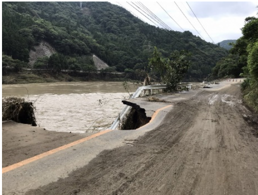
令和2年7月豪雨 出典) 福岡市
