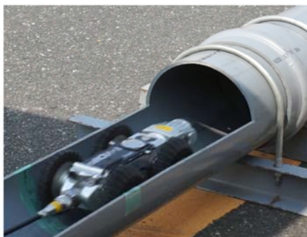
TVカメラによる劣化状況調査
