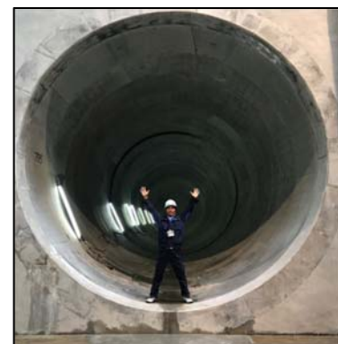
雨水管（内径5m）」
