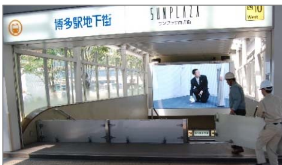
地下街管理者による止水板設置
