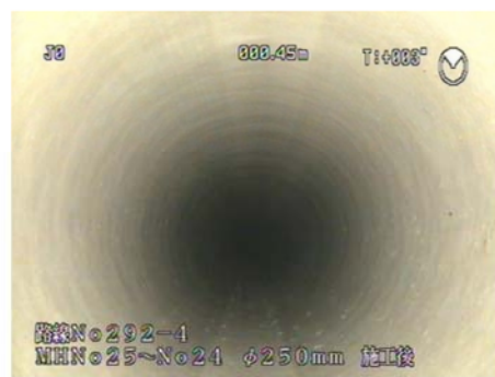
施工後（管更生）
