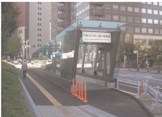
地下空間を利用した駐輪場 (天神ふれあい通り駐輪場)
