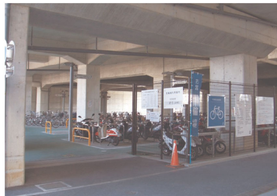
高架下を活用した駐輪場 (千早駅北駐輪場)
