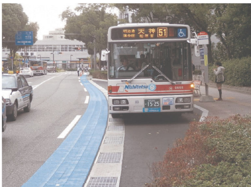
市道吉塚停車場線（平成26年度整備）
