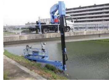
橋梁の点検状況
