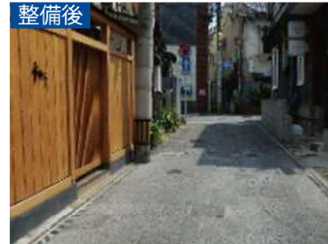
西中洲地区の石畳舗装
