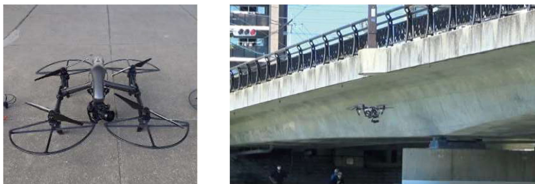
ドローンを活用した橋梁の点検状況
