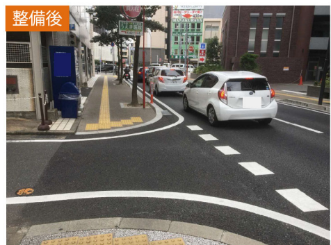
バリアフリー化された歩道
