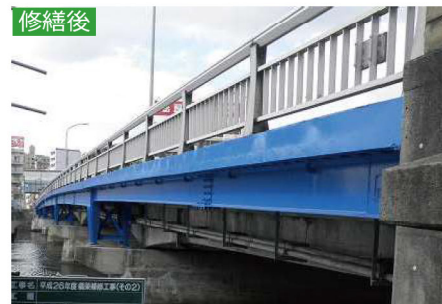
橋梁の修繕状況
