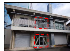
耐震補強したポンプ場
