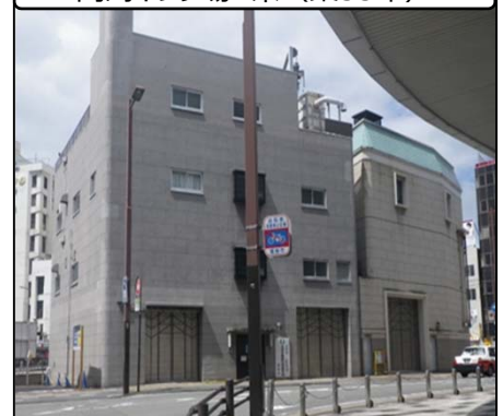
向島ポンプ場A系（築55年）
