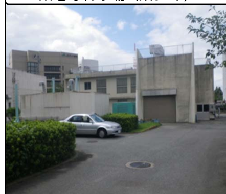
築地町ポンプ場（築52年）
