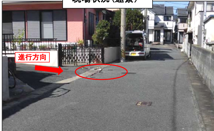
現場状況(遠景)
