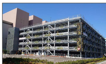
立体駐車場（令和2年5月供用）
