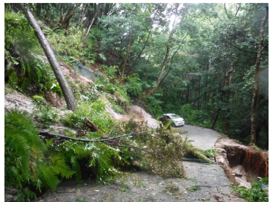
集中豪雨による林道の土砂災害
