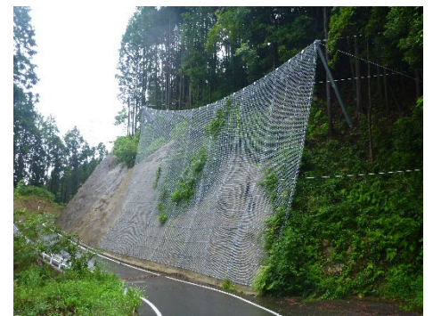
治山事業で整備した落石防護網
