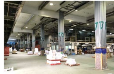
1階荷捌き所 階高約8m
