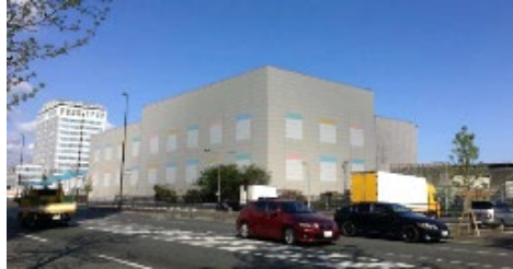
長浜臨港線沿いの全景
