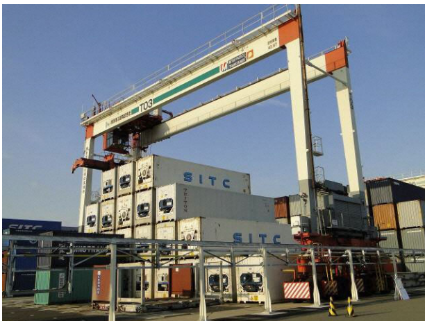
■電動トランスファークレーン
