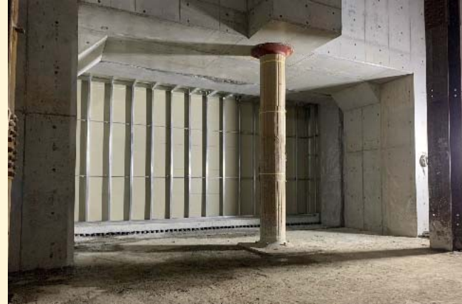
土木工事の進捗状況 (JR博多シティ接続部：地下2階)
