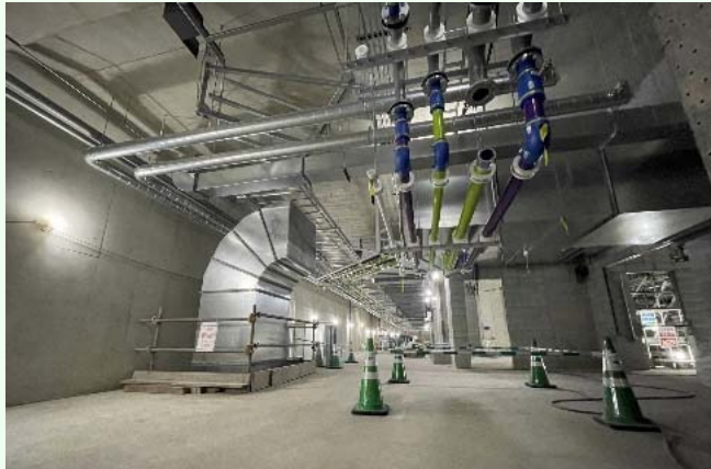
設備工事の進捗状況 (地下駅舎部)
