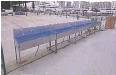
現場の手洗い場所の増設
