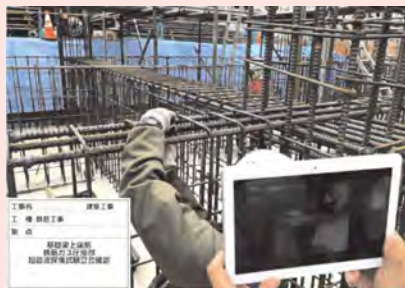
Webカメラを利用した遠隔検査
