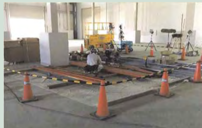
工事エリアの区画を設定して作業
