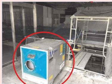
集塵機を設置し室内の換気を実施
