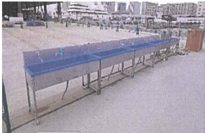
現場の手洗い場所の増設
