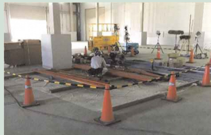
工事エリアの区画を設定して作業
