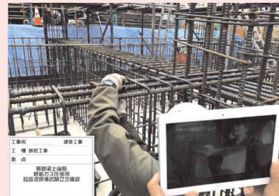
Webカメラを利用した遠隔検査
