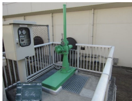
更新完了後（ゲート開閉機器）
