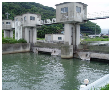
江ノ口川防潮水門
