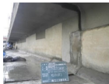
補修完了（断面修復）
