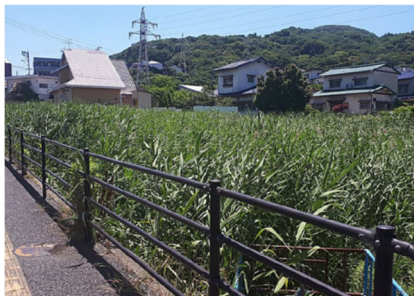
土砂の堆積による機能低下
