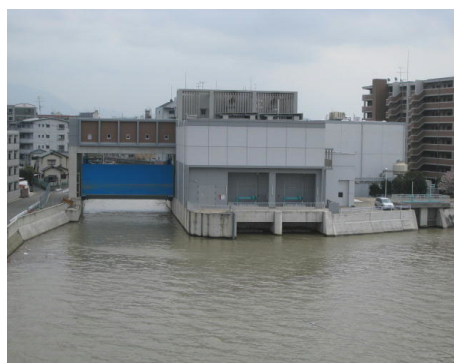
綿打川排水機場
