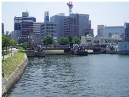
博多川可動井堰（下流）
