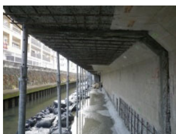
補修中（劣化部のはつり）
