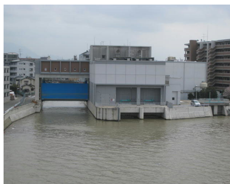
綿打川排水機場
