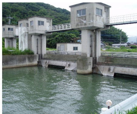
江ノ口川防潮水門
