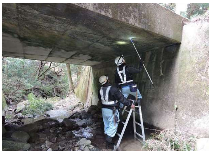
<林道橋梁の点検状況>
