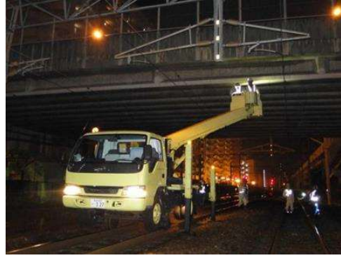
<詳細点検の状況：跨線橋>
