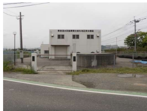
【太郎丸排水機場】
