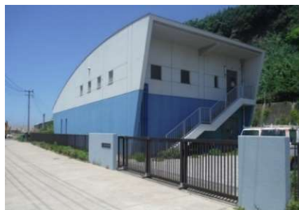
【小呂島集落排水処理場】
