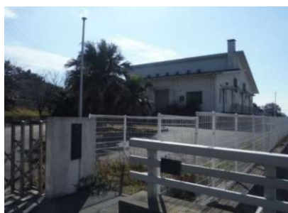
【西浦集落排水処理場】
