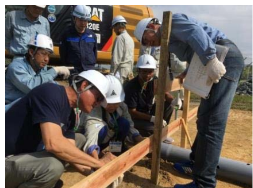
国内研修(丁張の設置)
