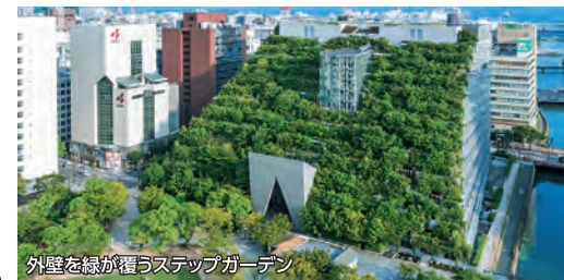
外壁を緑が覆うステップガーデン
