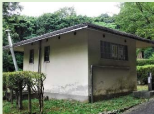
築 45 年が経過したトイレ
