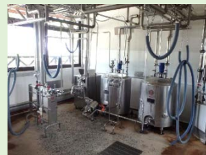
現在稼働していない 畜産加工研修施設
