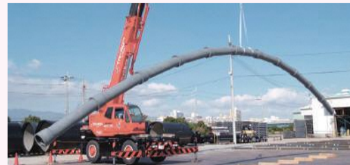
耐震管の吊上げ実験の様子 写真提供:一般社団法人日本ダクタイル鉄管協会
