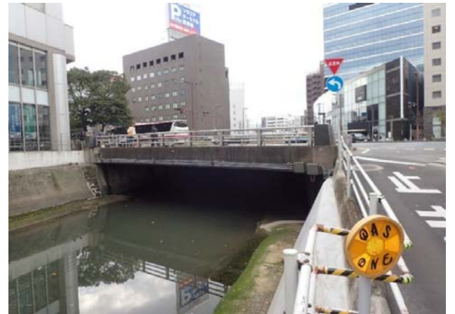
【橋の側面】下流側から撮影
