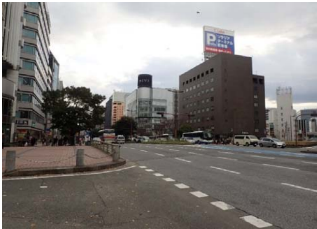
【橋の表面】北側から撮影
