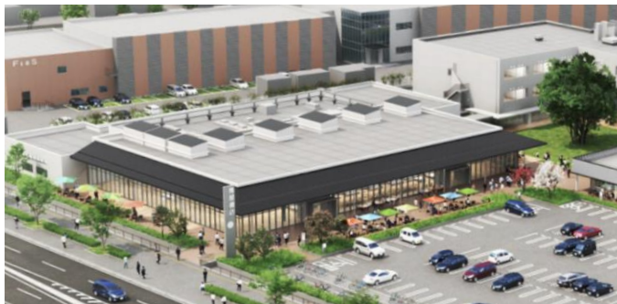
商業棟（蔦屋書店棟）外観
