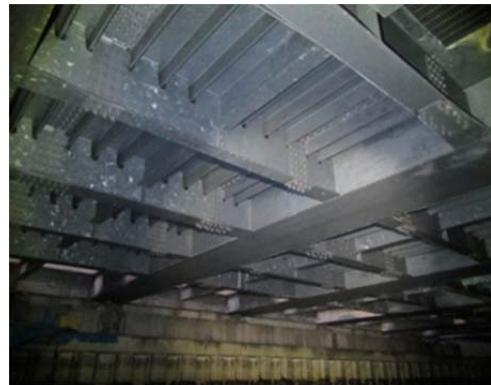
写真 1-12 鋼桁(渡辺通り4丁目)
