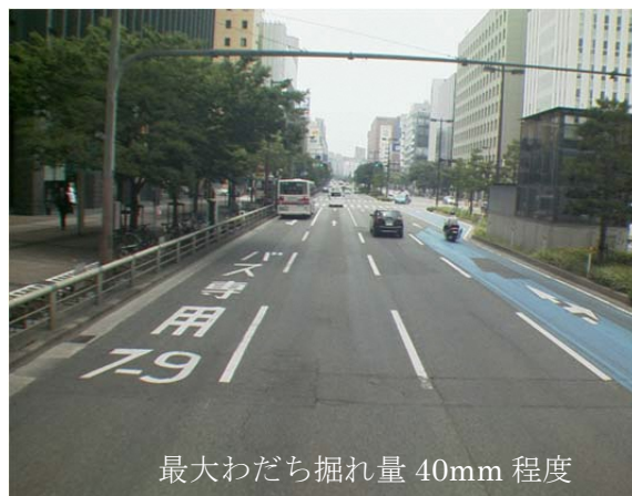
図 3-4 各区の路面状態 最大わだち掘れ量 (延長ベース)
