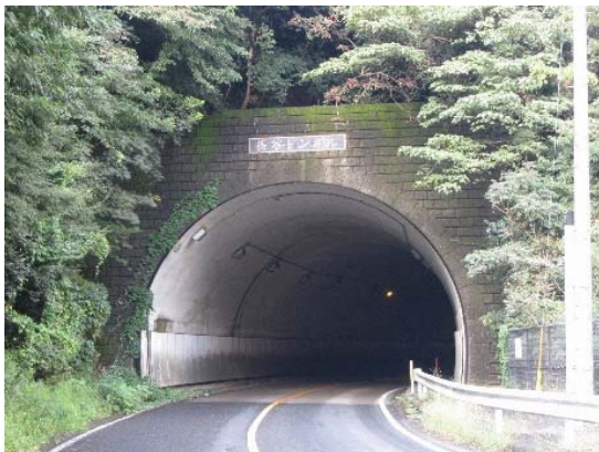
写真 1-1 山岳トンネル (NATM) (長谷トンネル)
