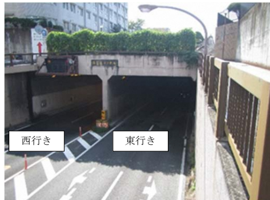
写真 1-2 開削トンネル (筑紫丘トンネル)
