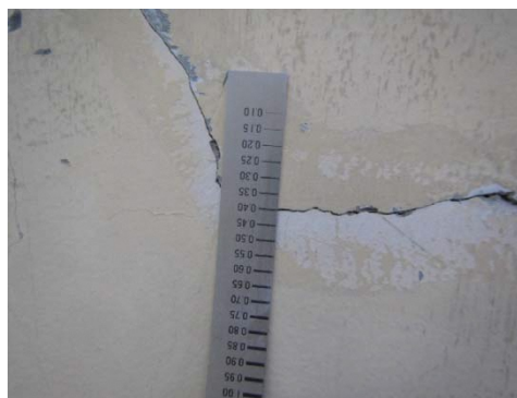
写真 3-6 損傷例：側壁のひびわれ 対策区分Ⅲ
