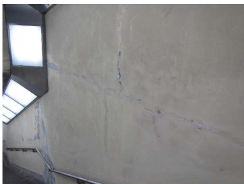
写真 3-6 損傷例：側壁のひびわれ 対策区分Ⅲ
