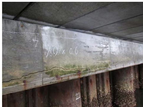
写真 3-10 損傷例：橋脚梁部のうき 対策区分Ⅲ
