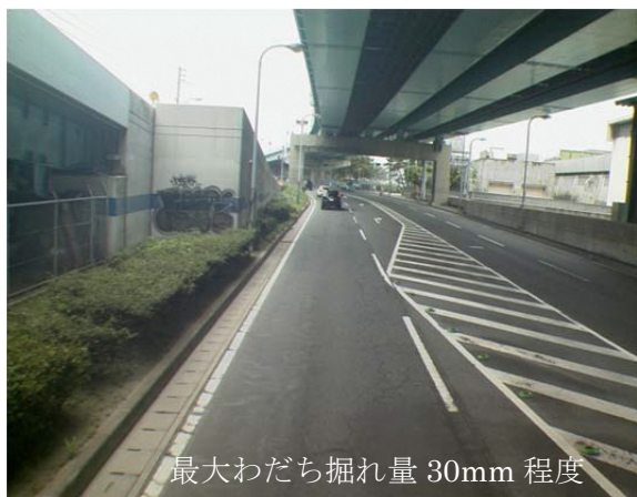
図 3-4 各区の路面状態 最大わだち掘れ量 (延長ベース)
