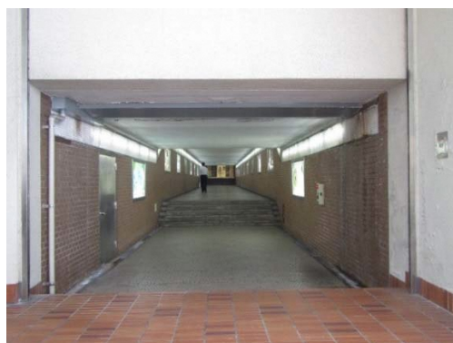
写真 1-8 渡辺通り地下通路
