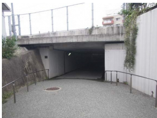
写真 1-7 名島地下通路
