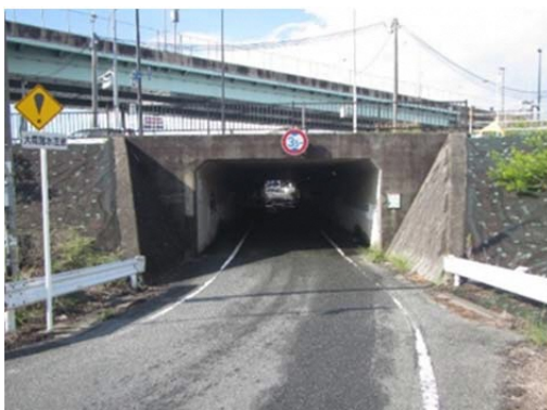
写真 1-3 松島アンダーパス① (管理対象は電気設備のみ)
