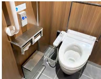
便器や手すりを認識しやすいよう、背面部はコントラストのある色としている。
