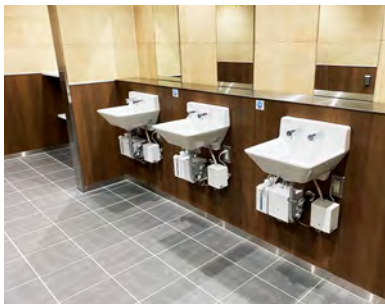
床と壁にコントラストがあり、空間認識がしやすい。洗面台を認識しやすいよう、背面部は洗面台とコントラストのある色としている。
