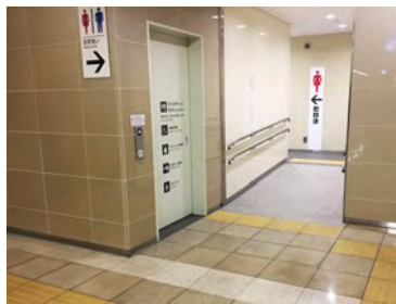
トイレ出入口の段差解消(スロープ化)
